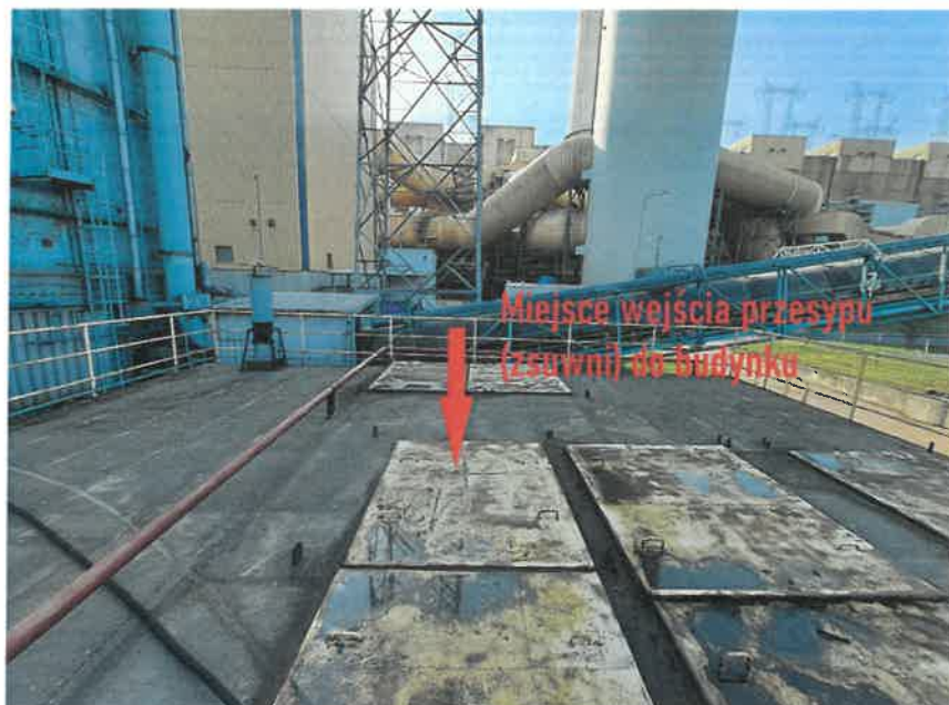
Zdjęcie nr 2 miejsce wejścia przesypu (zsuwni) do budynku A-7.5.
