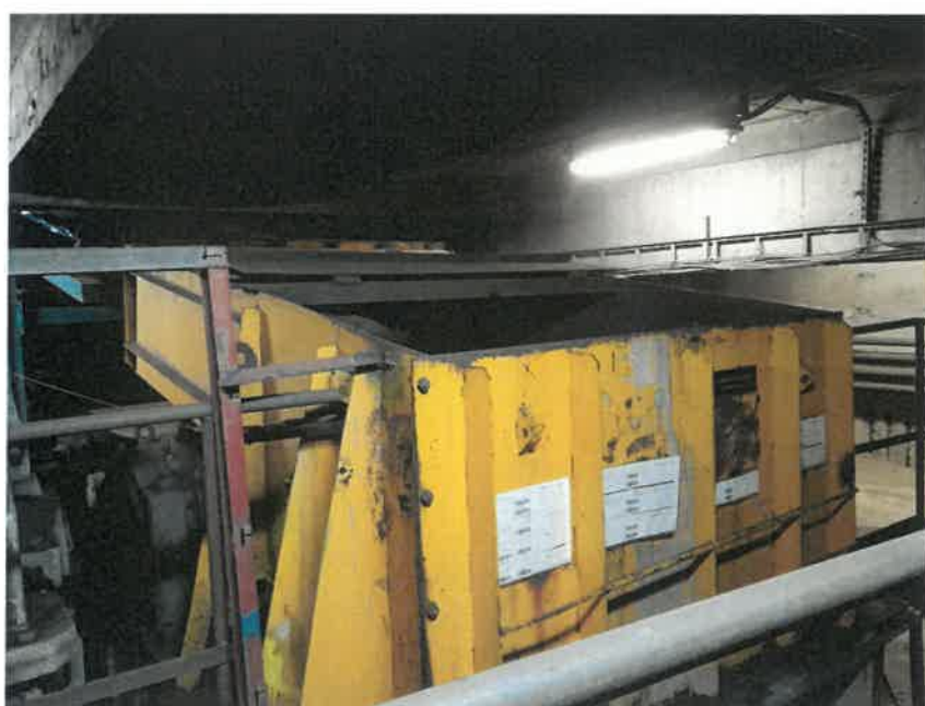
Zdjęcie nr 2 Węzeł przesypowy na którym ma zostać zabudowana zsuwnia.
